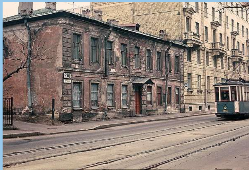
Вид здания в 1985 г. Источник: группа в VK.com «Типичный Васильевский остров».
